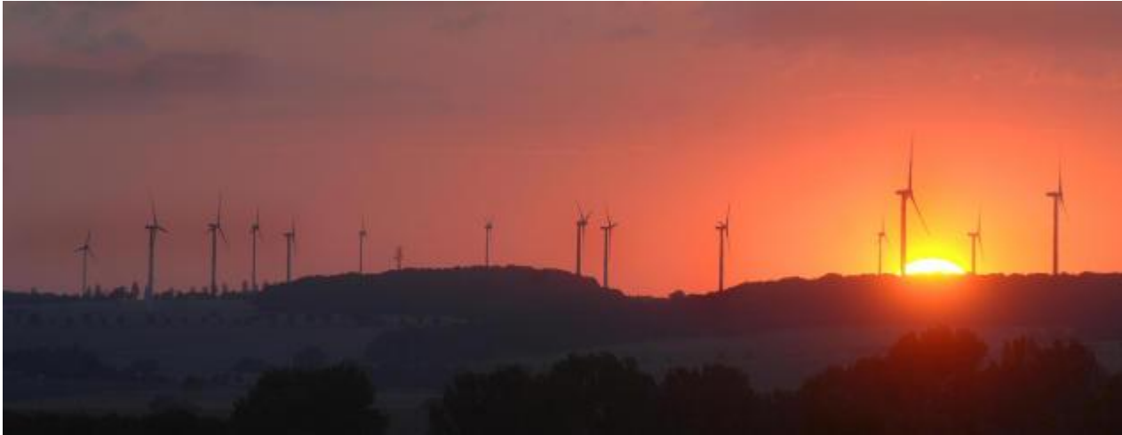
In Thüringen stehen inzwischen 834 Windkraft-Anlagen. Foto: Norman Meißner
