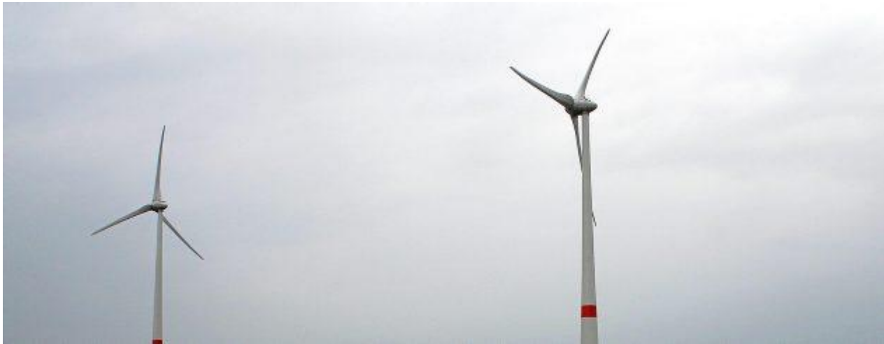
Blick auf die beiden Windr der bei Treppendorf. Foto: Heike Enzian
