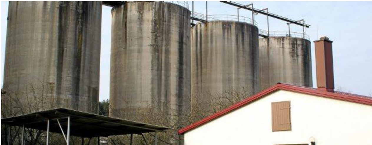
Die Silotürme der Agrargenossenschaft Engerda - Heilingen stehen seit Jahren leer. Mit einer Höhe von rund 20 Metern sind sie weithin sichtbar. Die jetzt geplanten Windkraftanlagen in der Nachbarschaft sollen mit 200 Metern zehnmal so hoch sein. Foto: Thomas Spanier
