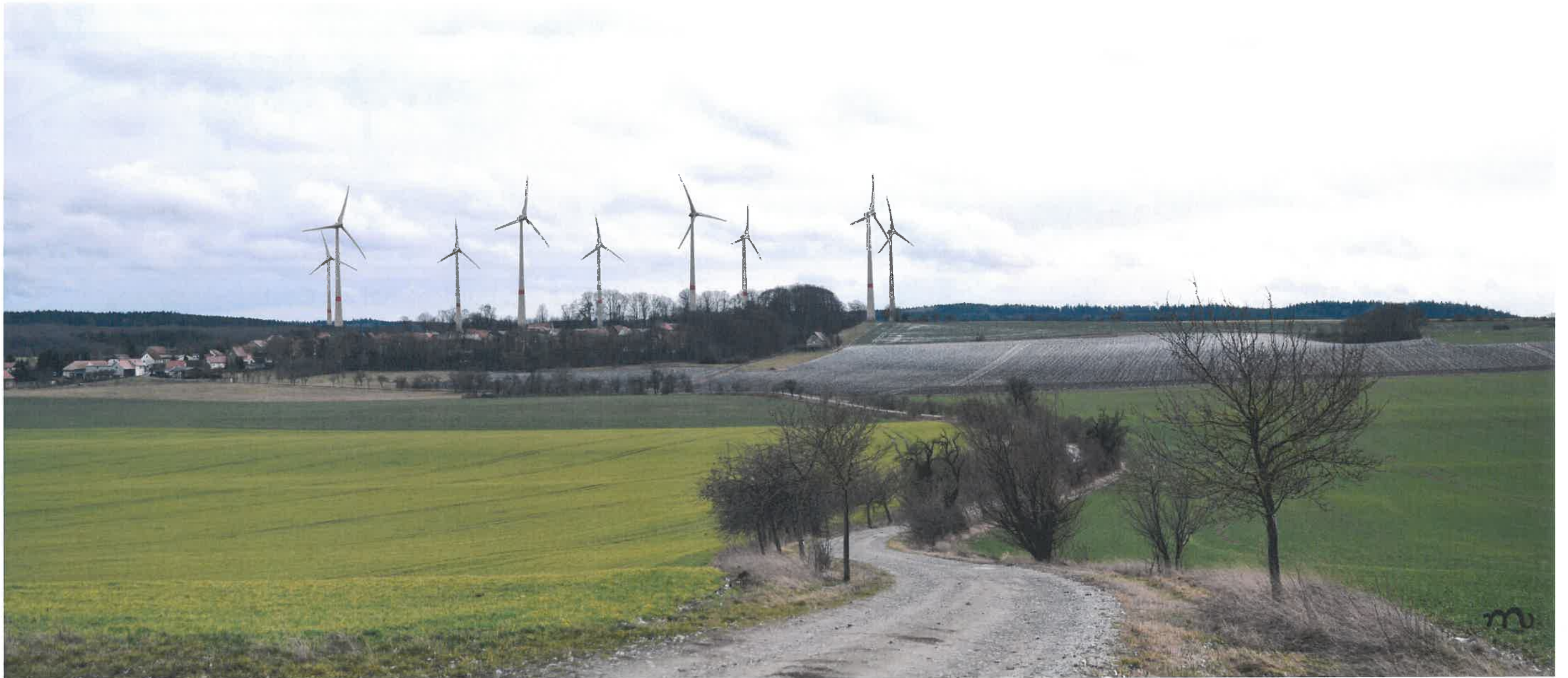
Blick vom Gothewanderweg bei Hochdorf in Richtung der möglichen WEA des Vorranggebietes W-11 – Neckeroda
